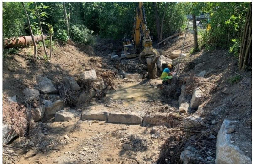
Pendelrampe im Bau mit Wasserhaltung
