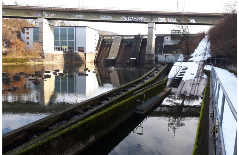
Ansicht des bestehenden Raugerinnes, das zurückgebaut wird, im Unterwasser des KW Wettingen
