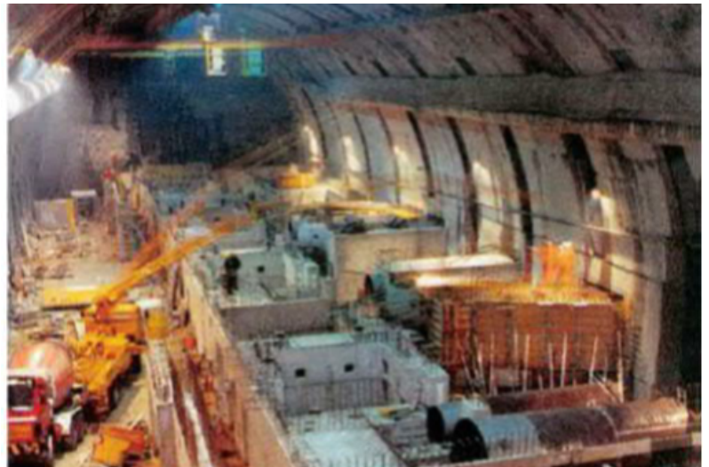
Centrale Unteraa, chantier salle des machines
