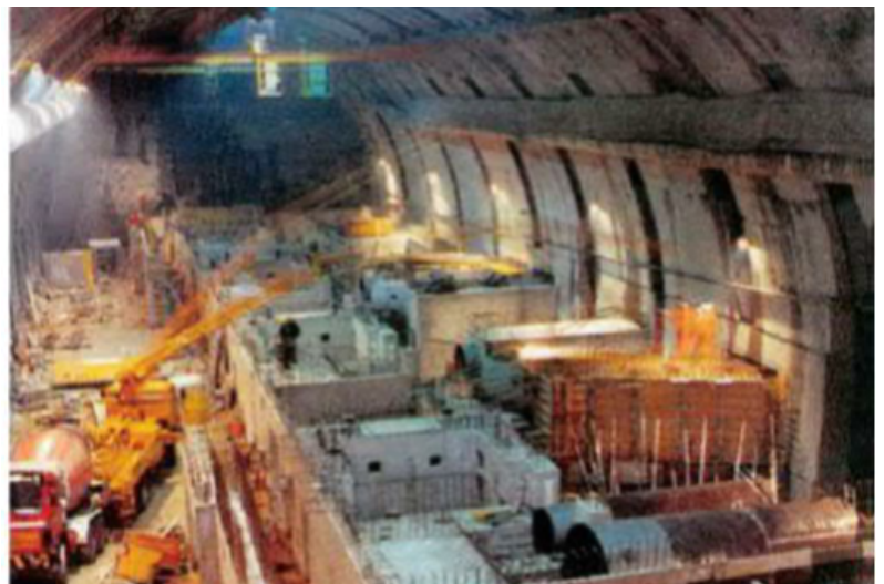
Centrale Unteraa, chantier salle des machines
