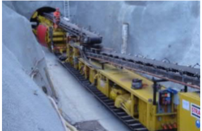
TBM Ø 3.00 m pour excavation puits blindé
