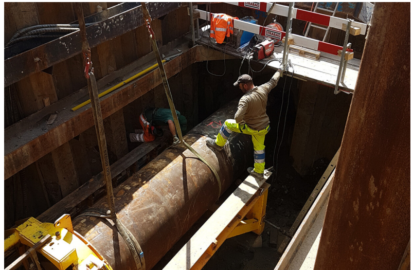
Startgrube Pressbohrvortrieb DN 1200, Aarestrasse
