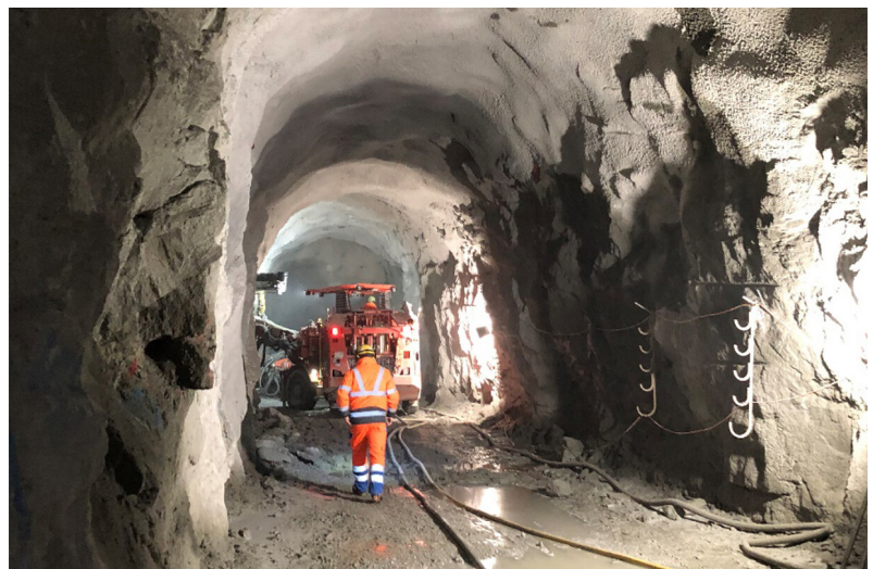
Zugangsstollen Apparatekammer Spitallamm
