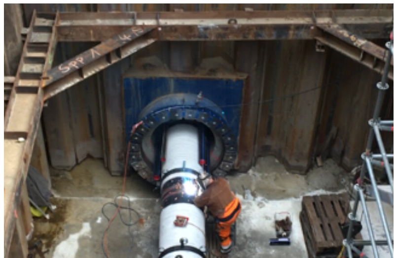
Rohrbauarbeiten Startschacht MCT (01. Juni 2020)
