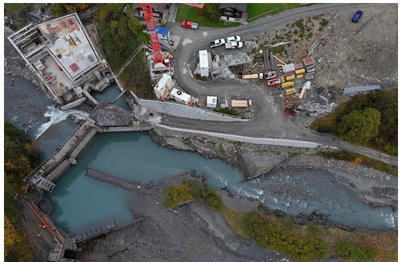
Wasserfassung Pradapunt: Bau während laufendem Betrieb KW Lügen, Übersicht
