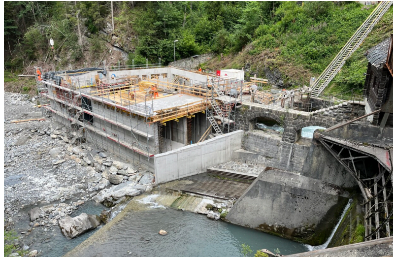
Wasserfassung Pradapunt: Erstes Baujahr unter laufendem Betrieb KW Lügen
