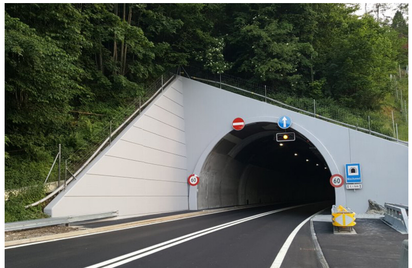
Nordportal, Sanierte Tunnelröhre, 12.05.2019
