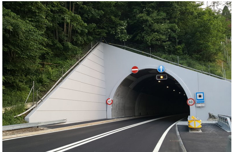
Nordportal, Sanierte Tunnelröhre, 12.05.2019
