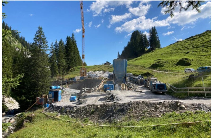
Perimetro del cantiere alla presa d'acqua
