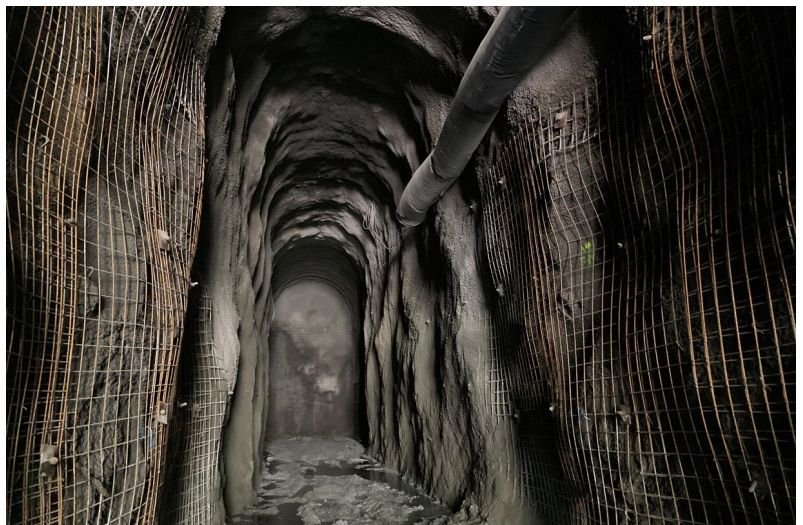
Réalisation d'une protection anti-éruption dans la galerie de dessablage
