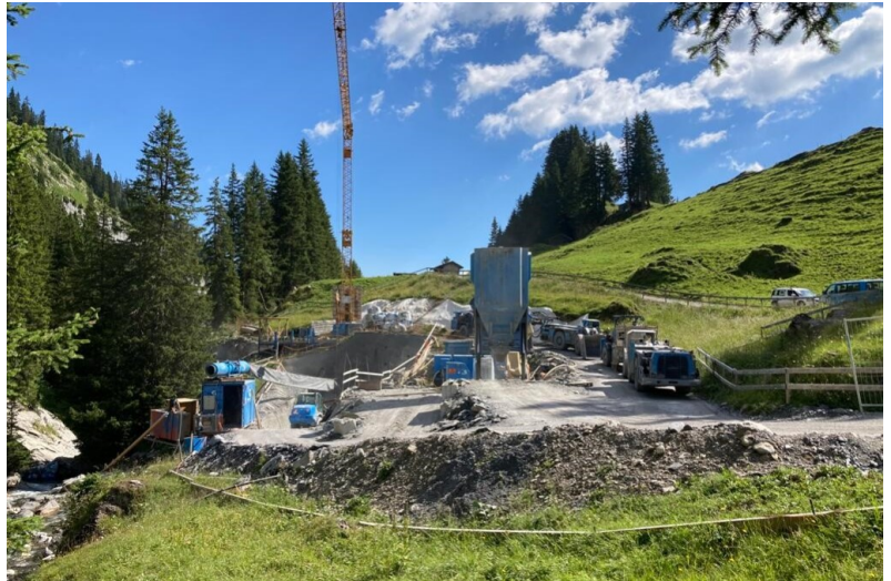
Périmètre du chantier près de la prise d'eau
