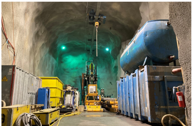
Caverne en tête de puits avec installations Raise-Boring
