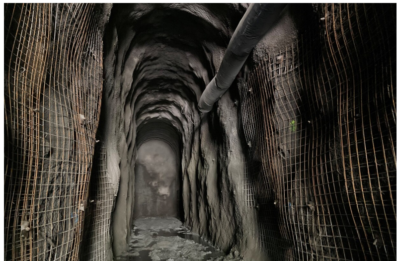
Réalisation d'une protection anti-éruption dans la galerie de dessablage
