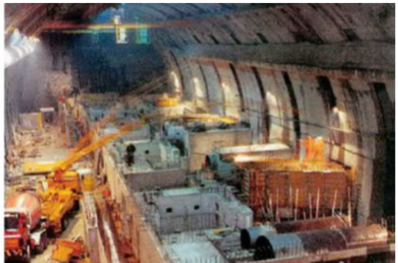
Centrale elettrica di Unteraa, cantiere della sala macchine
