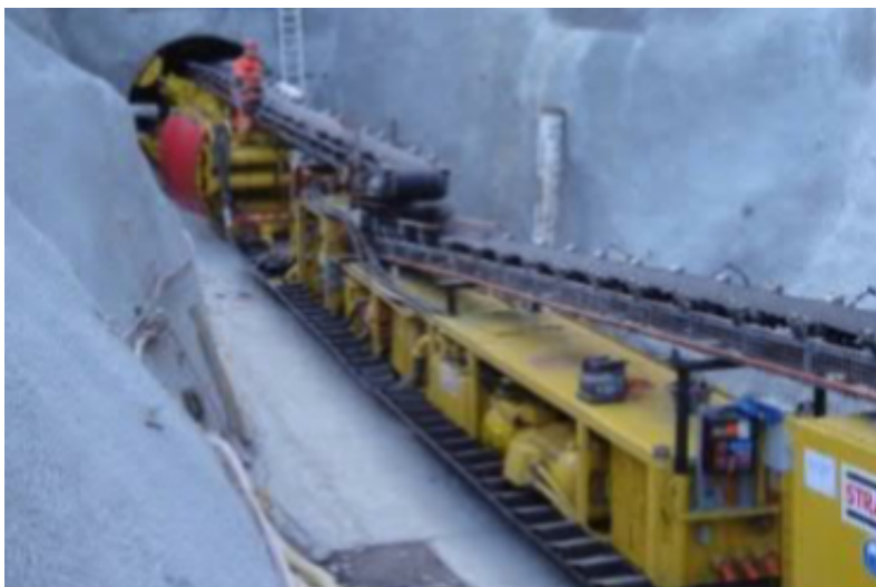
TBM Ø 3.00 m per scavo tunnel/pozzo piezometrico
