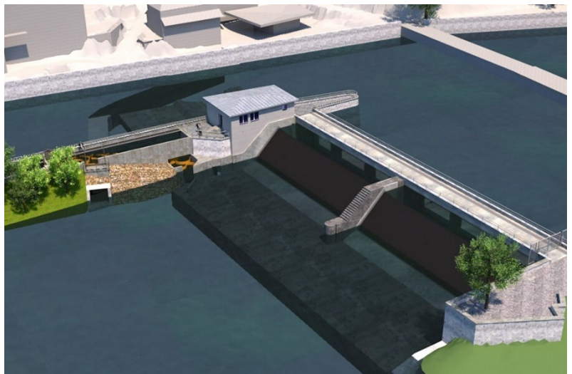
Visualisation du nouveau barrage et de la passe à poissons à méandres
