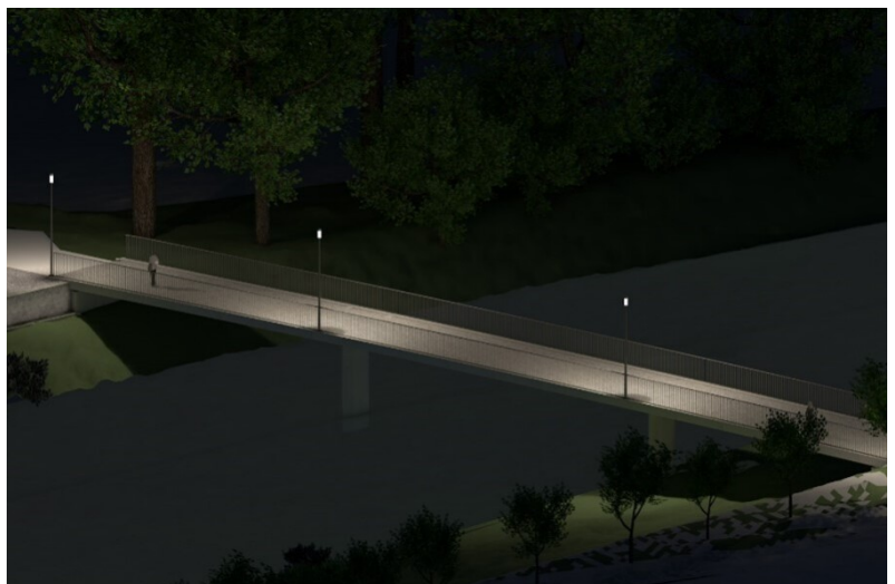
Nouveau pont de Platzspitz pour accéder au barrage
