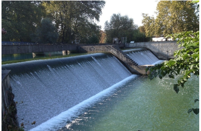
Barrage existant avec deux vannes-toit
