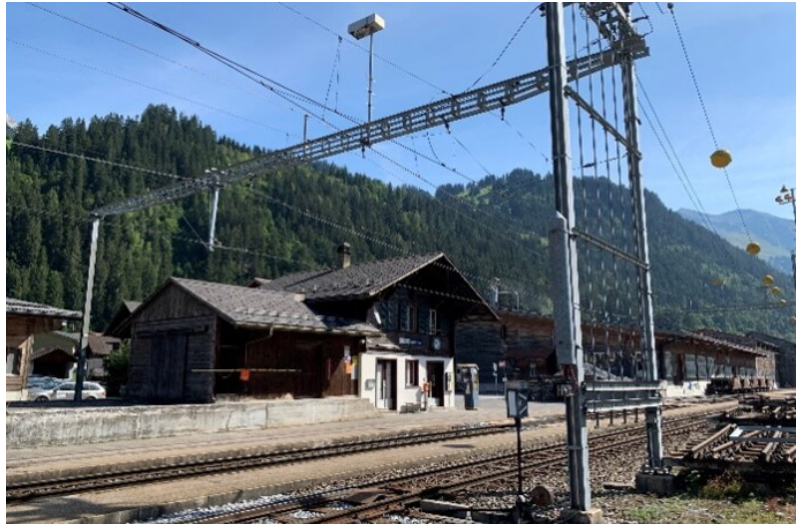
Bestehendes Bahnhofsgebäude St. Stephan
