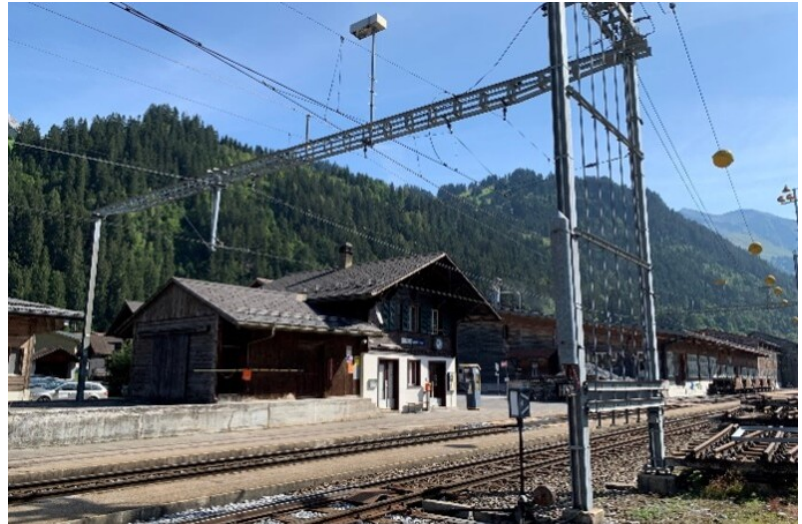
Bestehendes Bahnhofsgebäude St. Stephan
