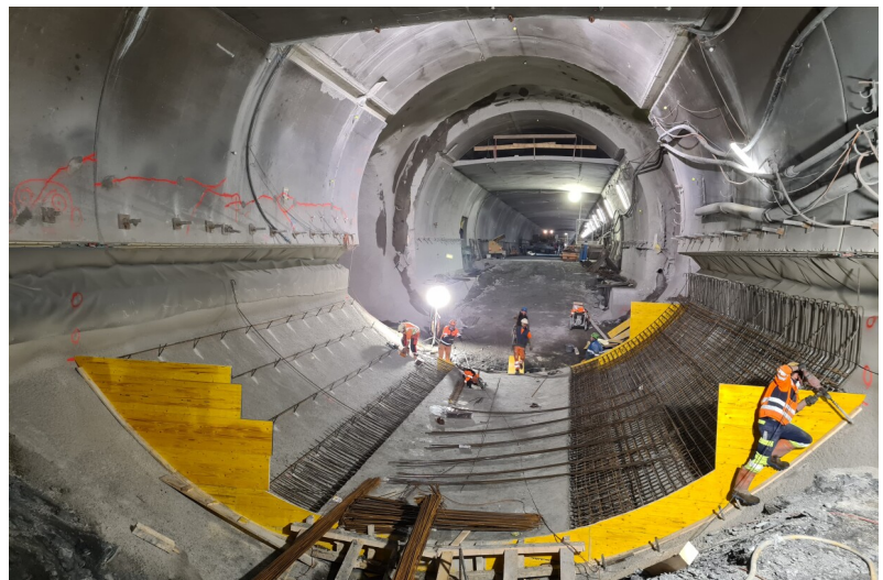
Vispertaltunnel im Bau
