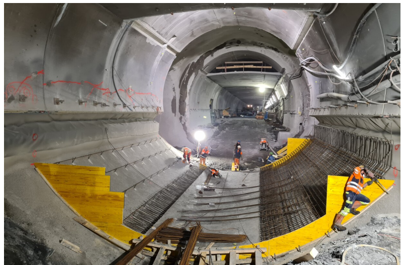
Vispertaltunnel im Bau
