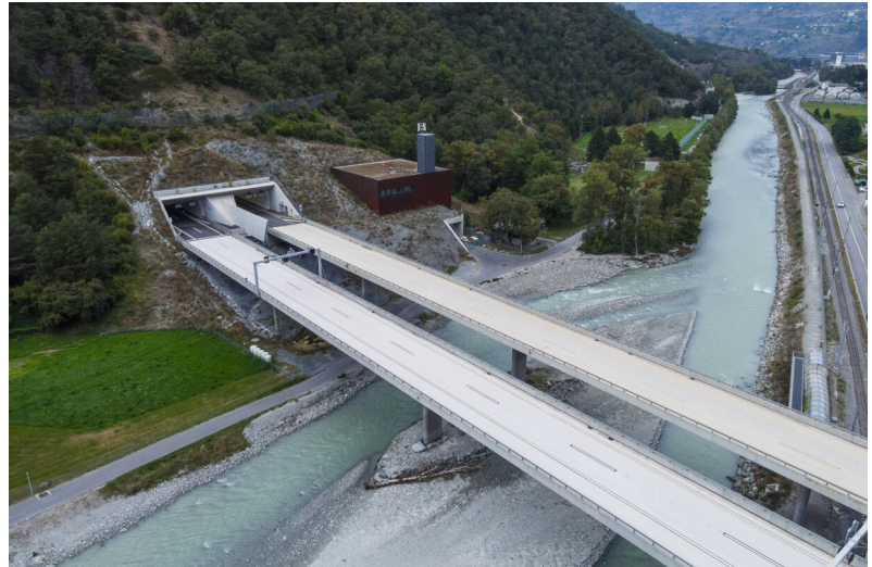
Eyholztunnel nach Abschluss der Bauarbeiten
