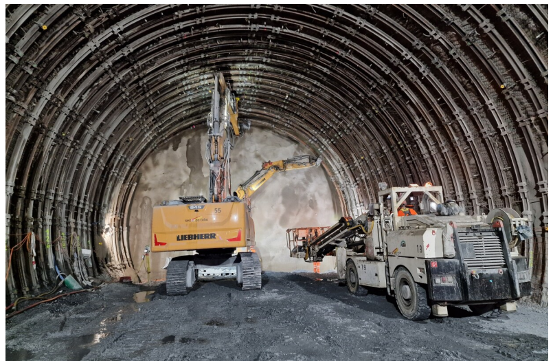
Konventioneller Vortrieb einer rund 350 m langen Störzone mit flexiblem Bogenausbau
