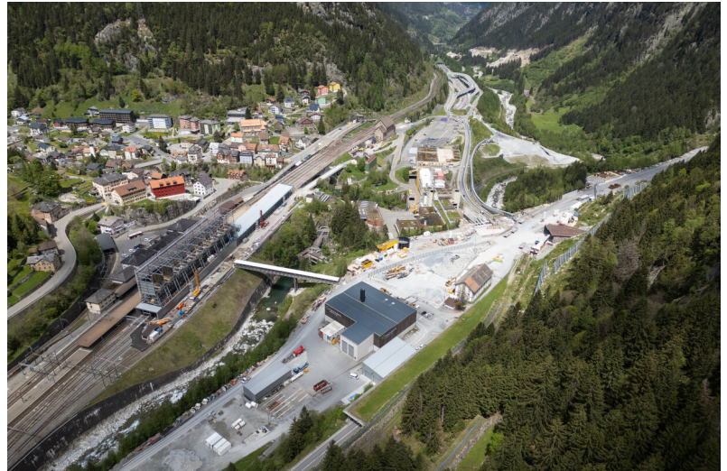
Übersicht Installationsfläche mit Bahnverladeanlage
