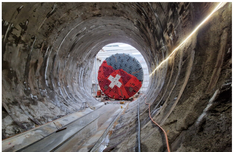
Montage S-Tunnelbohrmaschine vor Startröhre
