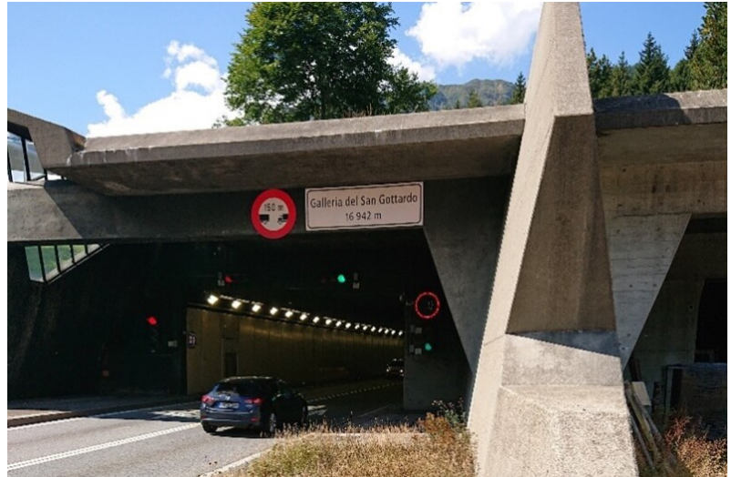
Südportal San Gottardo Tunnel
