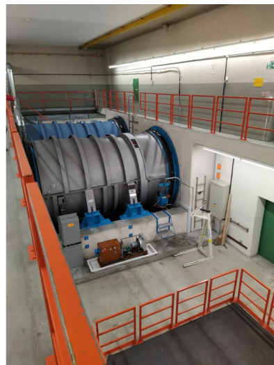
Centro di ventilazione di Göschenen
