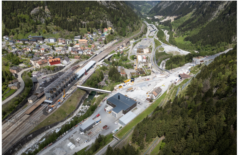
Aperçu de la surface d'installation avec l'installation de chargement/déchargement
