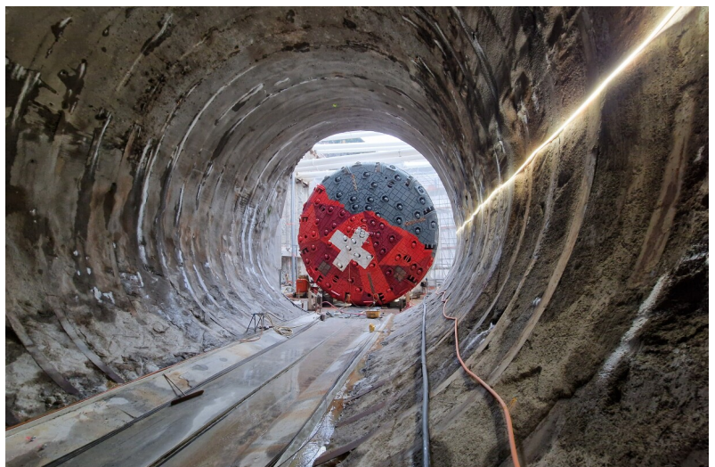
Montage du tunnelier devant le tube de départ
