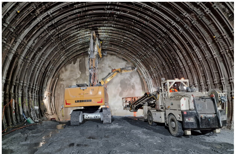
Avancement conventionnel d'une zone de perturbation d'environ 350 m de long avec soutènement flexible en voûte
