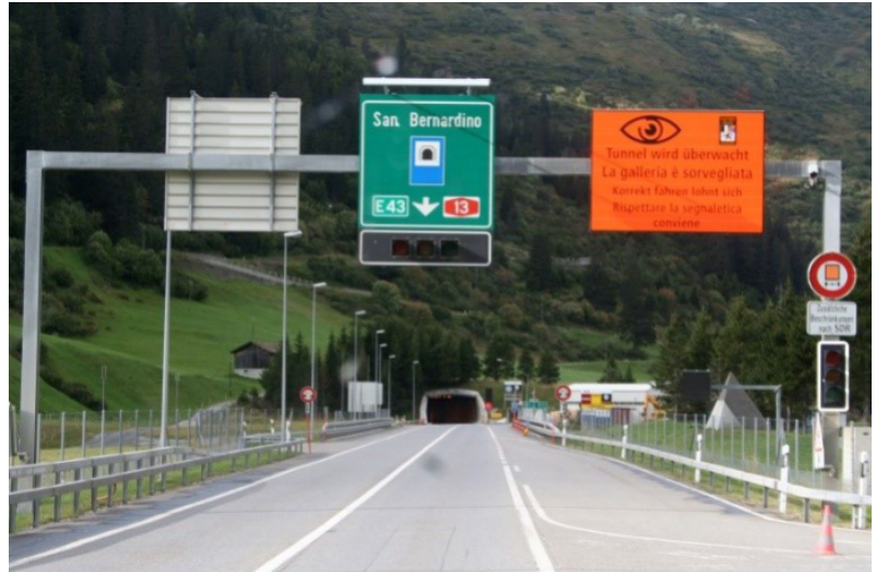
Portale nord Tunnel San Bernardino
