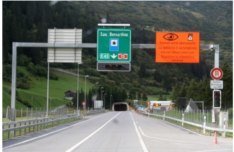
Portail nord du tunnel de San Bernardino
