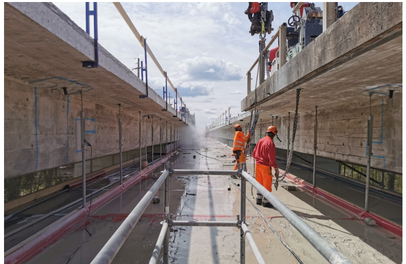
Abriss des Mittelstreifens mit einer für die Verkehrsführung erforderlichen Vergrösserung
