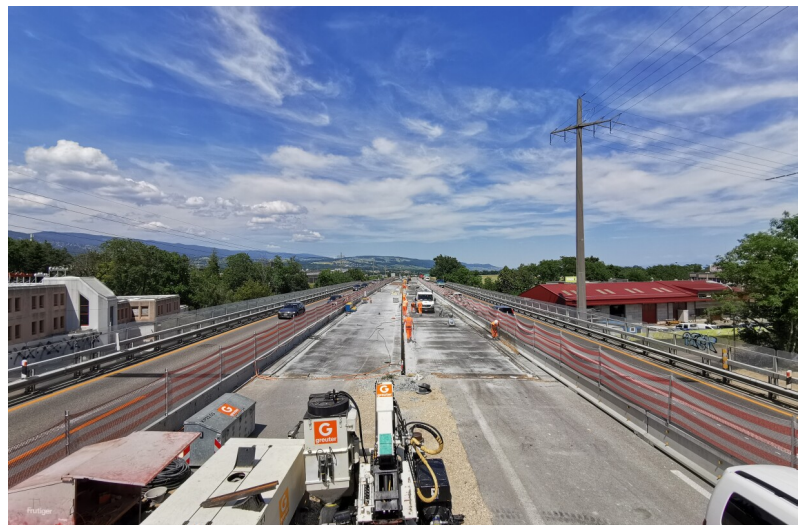
Ricostruzione spartitraffico con impalcato in CFAP e nuove barriere laterali
