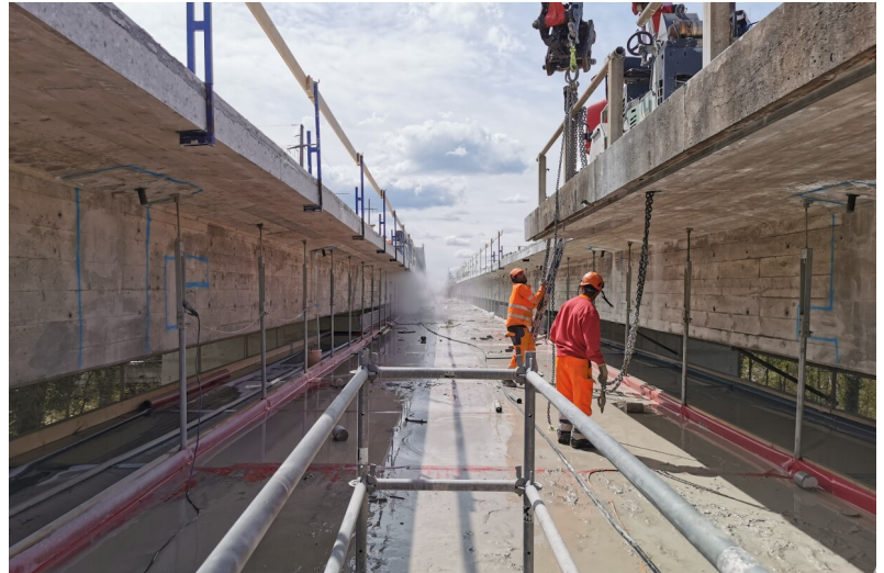
Demolizione spartitraffico prima di un ampliamento necessario per la gestione del traffico
