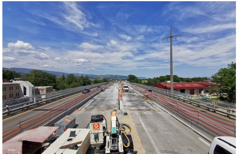
Reconstruction en TPC avec tablier en CFUP et nouvelles bordures
