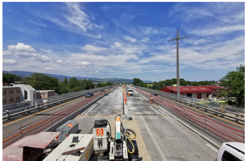
Reconstruction en TPC avec tablier en CFUP et nouvelles bordures
