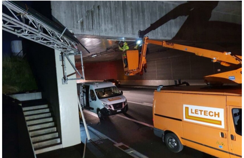
Montagearbeiten Überdeckung Alchenflüh
