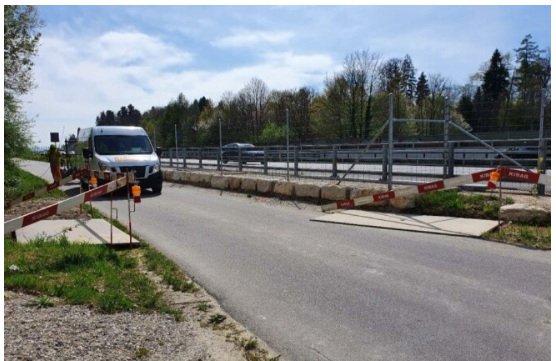
Sondagearbeiten für die LSA Koppigen
