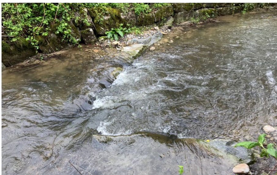
Bild 3: V-förmiger Blocksteinriegel zur Sohlenstabilisierung und Förderung von Kolken im Dorfbach Biberist, Q = \text{ca. } 0,3 \text{ m}^3/\text{s} (IUB Engineering AG).
