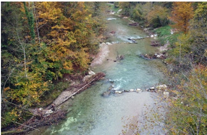
Bild 7: Blick in Fließrichtung im Herbst 2022, 6 Monate nach Einbau der ergänzenden ingenieurbioologischen Massnahmen, Q = 1,0 \text{ m}^3/\text{s} (IUB Engineering AG).
