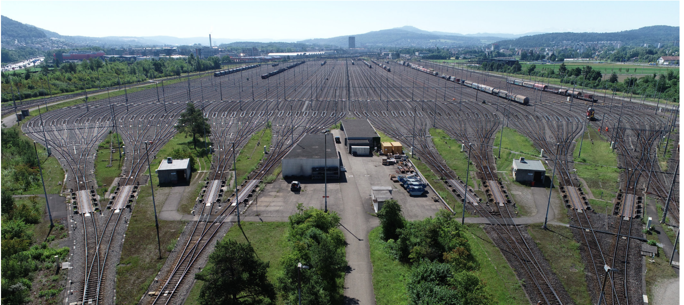
Rangierbahnhof Limmattal: Ablaufberg und Gleisfeld
