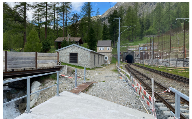
Albulatunnel II: Aussenansicht Technikgebäude
