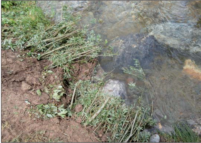
Abbildung 12: Uferanbindung einer Lenkbuhne mit Weidenbuschlagen (Fließrichtung von unten rechts nach oben links) Figure 12: Raccordement à la berge d'un micro-épi avec des lit de plançons (sens de l'écoulement d'en bas à droite à en haut à gauche)
