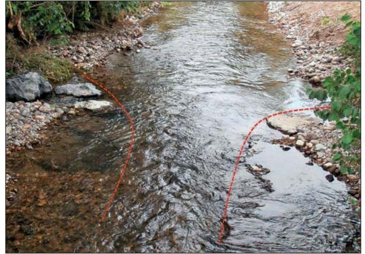
Abbildung 13: Strömungstrichter unterstrom der Brücke (GEWISS-km 9.790), im Bereich der ehemaligen Auflandungen (vgl. Abb. 6) mit Rot gestrichelt dargestellten Bühnhinterkanten (Blick in Fließrichtung, Q = 240 \text{ l/s} ) Figure 13: Entonnoir pour diriger le courant sous le pont (GEWISS-km 9.790) dans la région des anciens atterrissements (cf. Figure 6) avec les bords de fuite des épis en rouge traitillé (vue dans le sens de l'écoulement, Q = 240 \text{ l/s} )
