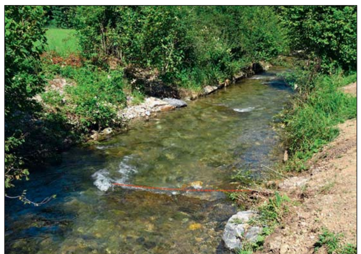
Abbildung 11: «Lenkbuhnenrampe» zwei Wochen nach Fertigstellung. Die Hinterkante der Lenkbuhnen bildet eine Linie (rot gestrichelt) und die Steine wurden mit in Fliessrichtung um 5 bis 10 cm ansteigender Oberfläche eingebaut (Blick in Fliessrichtung, Q = 460 \text{ l/s} )
