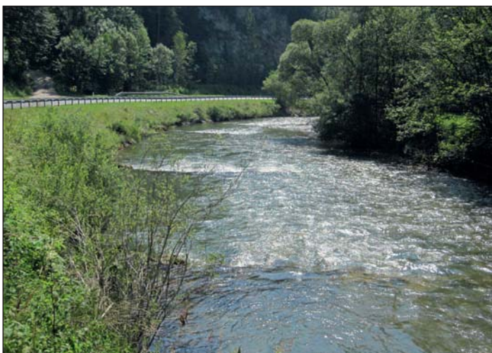
Abbildung 1: Lenkbuhnen zum Schutz eines Prallufers der Mürz/Steiermark. Die Lenkbuhnen schliessen unmittelbar an den bestehenden Blocksatz am linken Ufer an, der vollständig erhalten werden konnte und seit dem Einbau stabil ist (Blick in Fließrichtung; Mende 2012)
