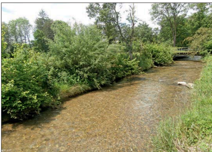
Abbildung 5: Auflandungen oberstrom der Brücke bei GEWISS-km 9.790 (Blick in Fließrichtung, Q = 450 l/s) Figure 5: Atterrissement en amont du pont à GEWISS-km 9.790 (vue dans le sens d'écoulement, Q = 450 l/s)
